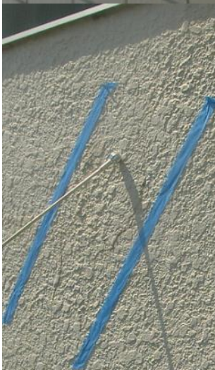
打音検査状況
